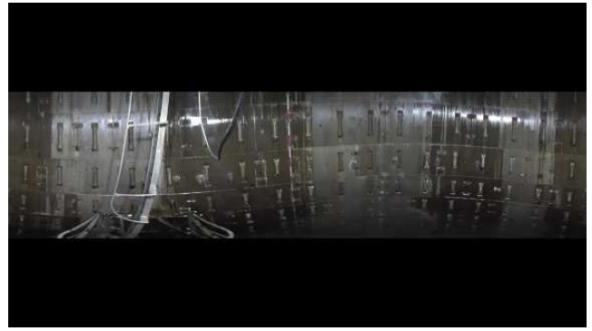
全周撮影型カメラを用いた集水井内部の撮影例②
